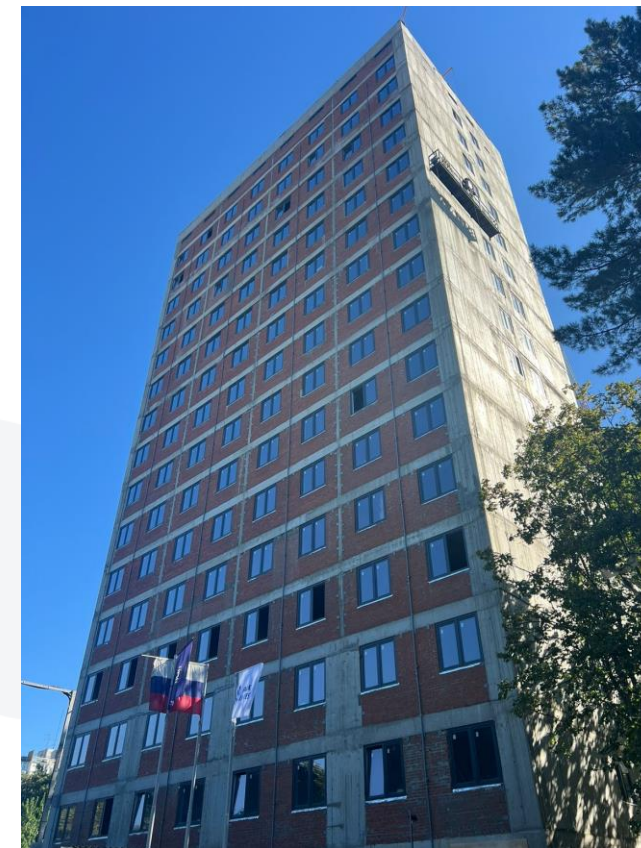
В стадии строительства два 17-ти этажных корпуса
